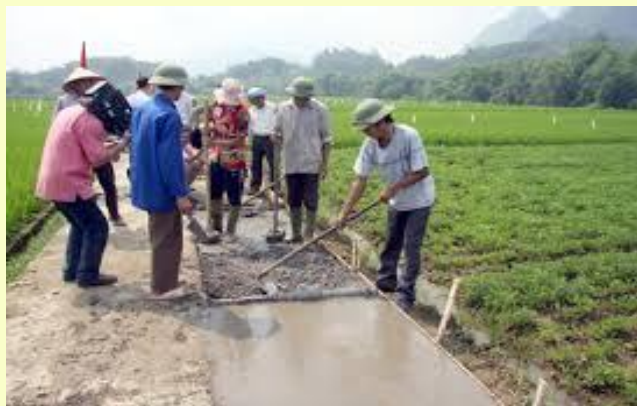
Nhân dân tham gia làm đường giao thông nông thôn trong xây dựng Nông thôn mới
